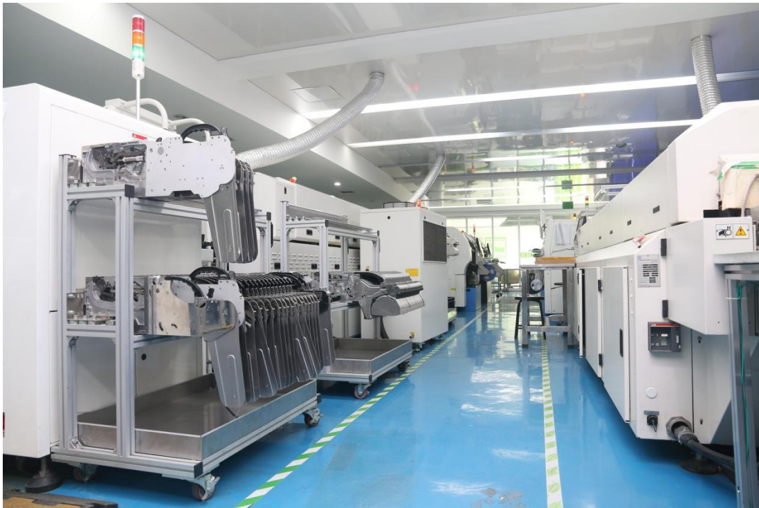
S104 电子工艺实训室
