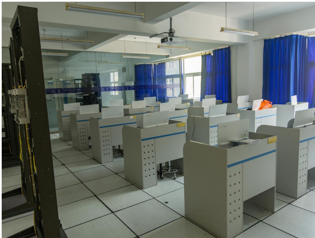
N215 NGN 软交换技术实训室
